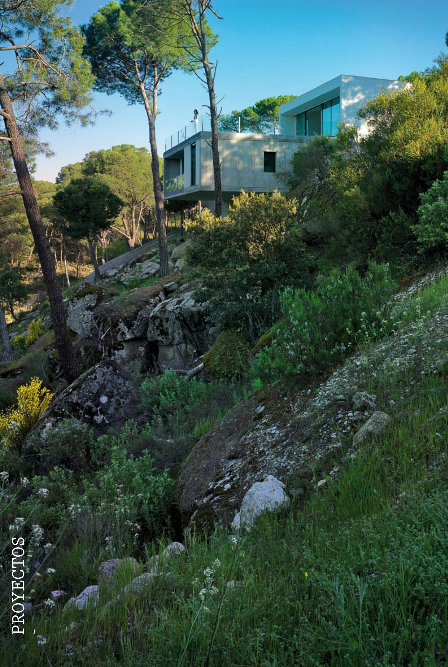
VIVIENDA EN LAS AFUERAS DE MADRID Autor MOREMAS . KENNETH KIM Y PAULA ROSALES Constructor EMENDO Colaborador TOMÁS DALDA Superficie 315 M² Realización 2010 Fotografía JESUS GRANADA
